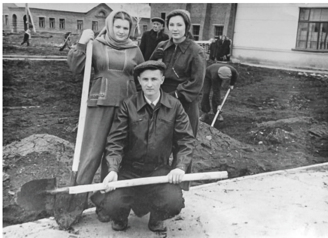
Фото 5. Студенты (Людмила Возняк, Валерия Королева-Мунц, Виктор Саушев) копают траншеи для коммуникаций учебного корпуса в Кировском районе, 1957 год.
