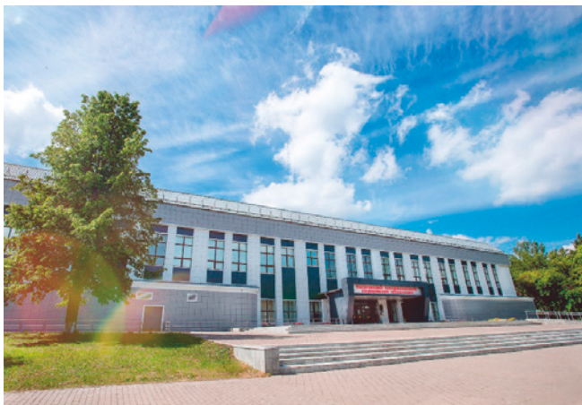
Фото15. Обновленный главный корпус на улице Ворошилова, 22а, август 2021 года.
