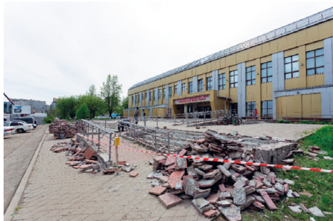
Фото 13. Главный корпус на улице Ворошилова, 22а во время реконструкции крыльца.
