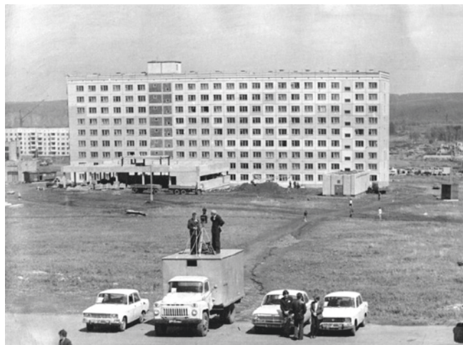
Фото 12. Стройка нового общежития.
