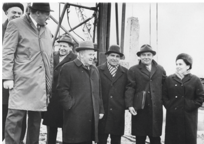
Фото 8. Делегация на строительстве главного корпуса. Второй справа – ректор КГМИ А. Д. Ткачев.
