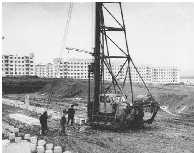
Фото 7. Стройка нового главного корпуса в Ленинском районе.
