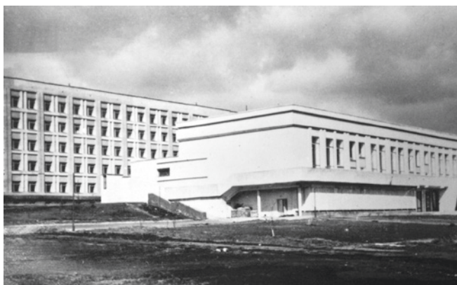
Фото 10. Стройка завершена. Вид нового главного корпус в Ленинском районе.
