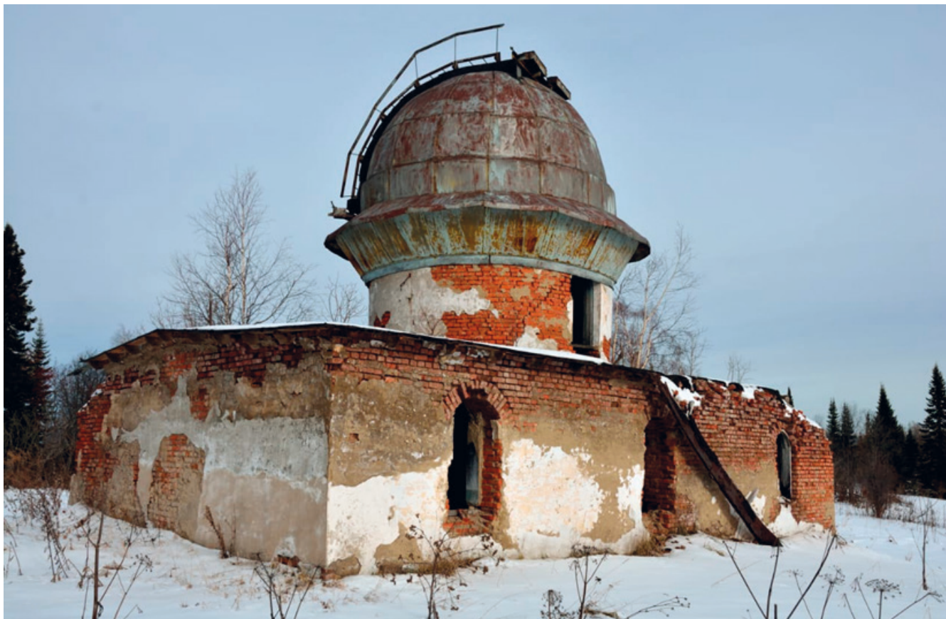
Рисунок 2. Обсерватория на горе Улу-Даг. Фотография начала XXI в.
